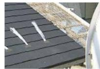
屋根材の大きな重なりと下葦材で漏水抑制。
